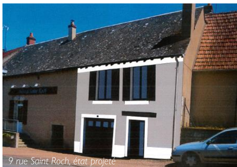
9 rue Saint Roch, avant travaux
